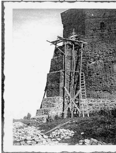
3. Renowacja wieży bramnej ok.1942-44 (ze zbiorów Muzeum Zbrojowni na Zamku w Liwie) fot. O. Warpechowski
